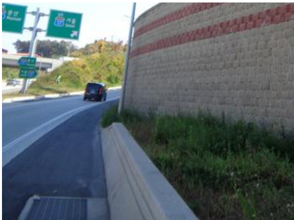
지반 기초부 상태양호
