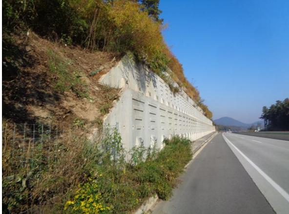
지반 기초부 상태양호
