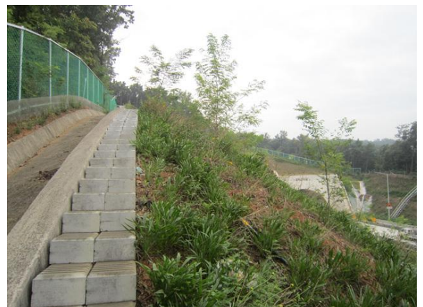
상부 성토부 전경
