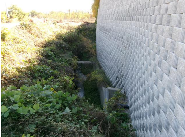
지반 기초부 상태양호
