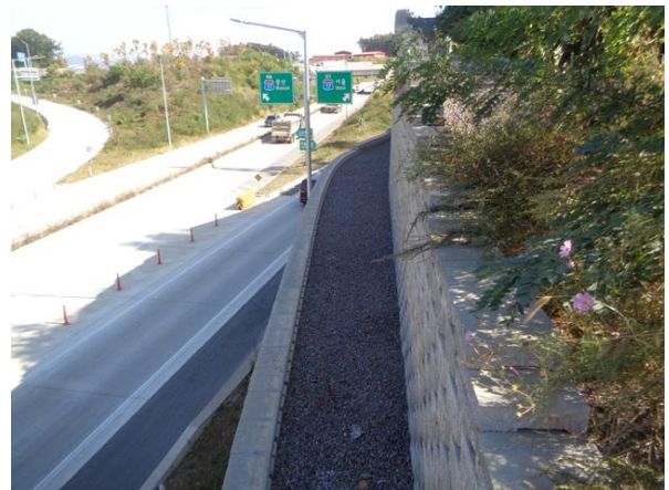
지반 기초부 상태양호
