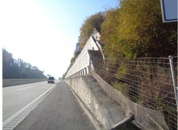
지반 기초부 상태양호
