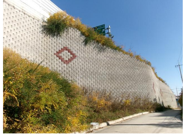
지반 기초부 상태양호
