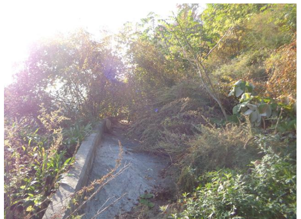
상부 성토부 전경
