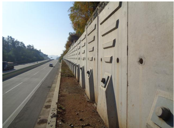
지반 기초부 상태양호
